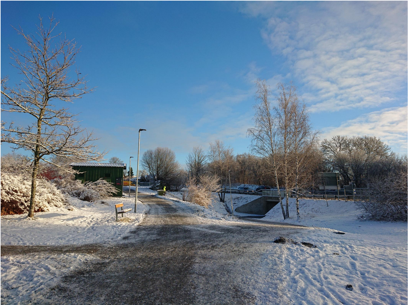
Figur 10: Foto vid punkt 4. GC-tunnel under leden. Bild från författaren 2024-12-04
